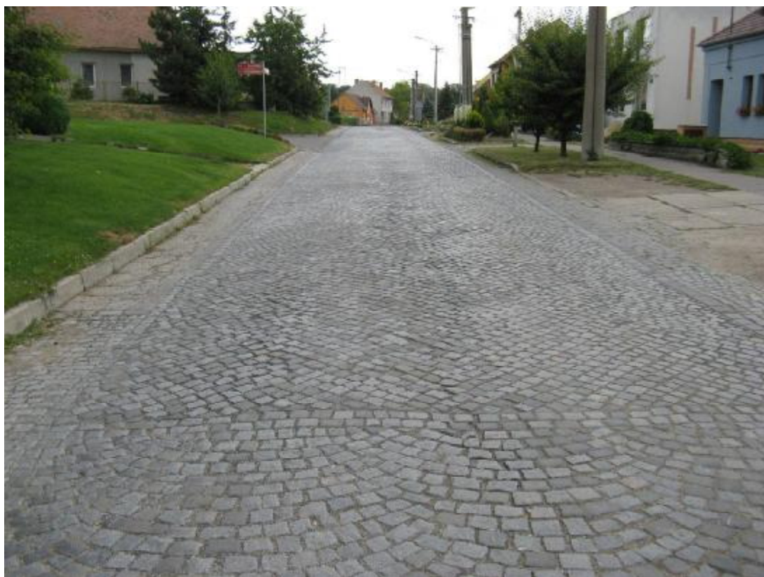
F22, km 36,290- Dlážděný povrch s výraznými plošnými deformacemi.
