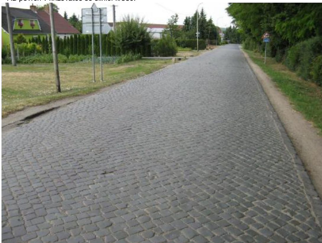
F05, km 35,715+ Dlážděný povrch s mírnými plošnými deformacemi a lokálně rozlomenými dlažebními kostkami.
