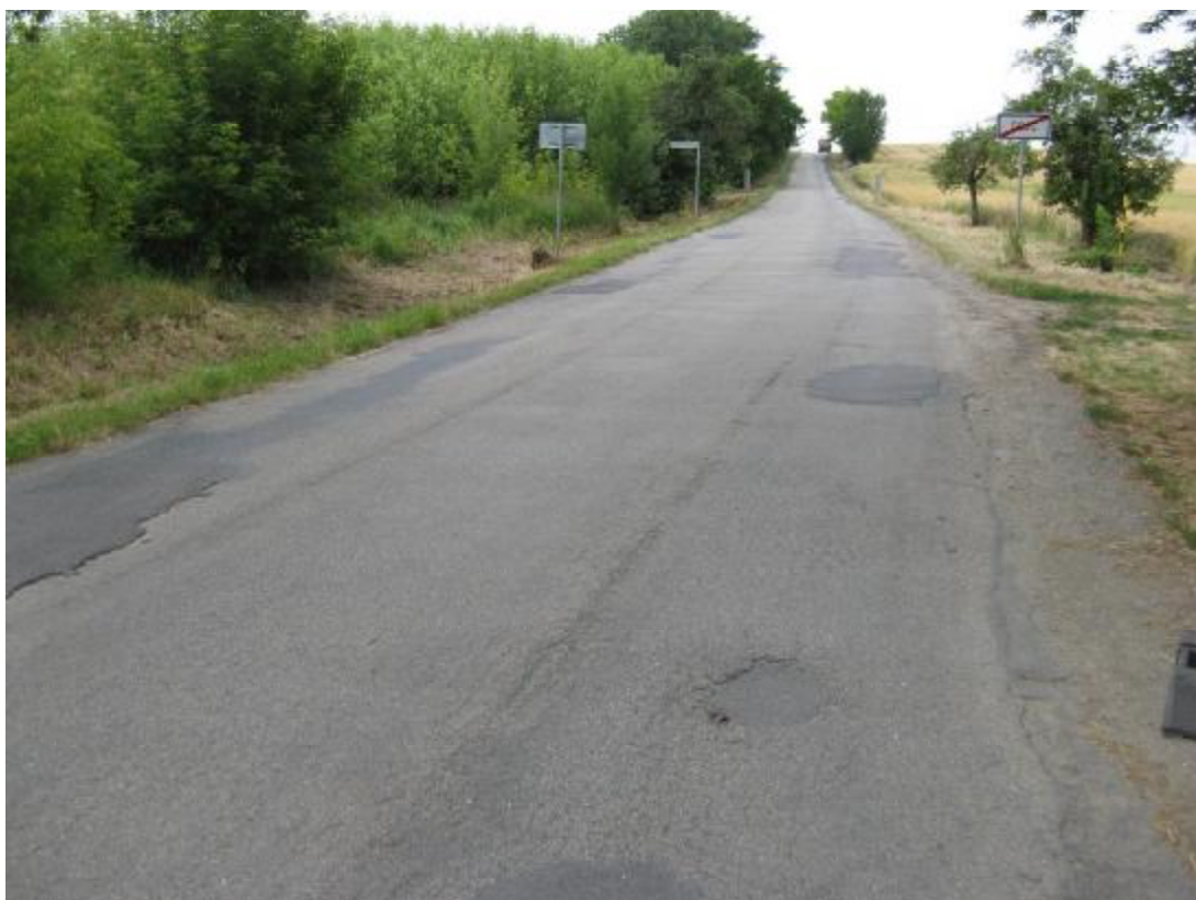
F27, km 36,570+ Část úseku s AB povrchem. Plošné deformace, vysprávkky a síťové trhliny.
